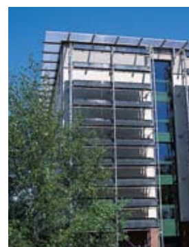
Рис. В.1.6-17 Монтаж на стене (наклонная поверхность)
