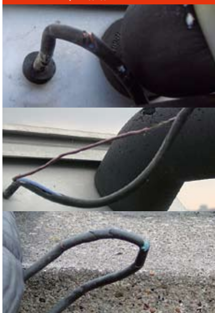
Рис. D.2.1-1 Незащищенные соединительные провода датчиков
