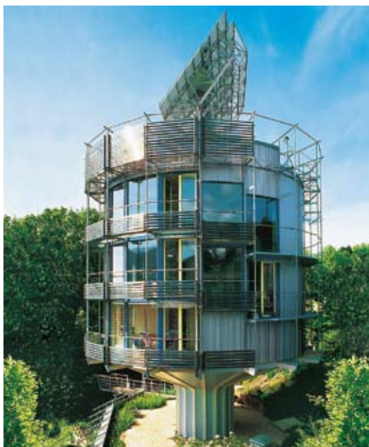
Рис. В.1.7-4 Коллектор как элемент дизайна здания Гелиотропа во Фрайбурге (Германия).
