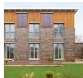
Рис. В.1.6-14 Вертикальный монтаж на стене
