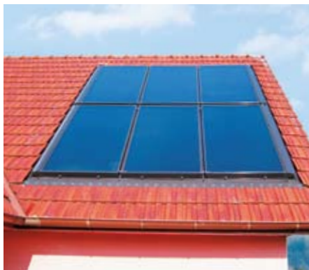
Рис. В.1.6-8 Встраивание в кровлю
