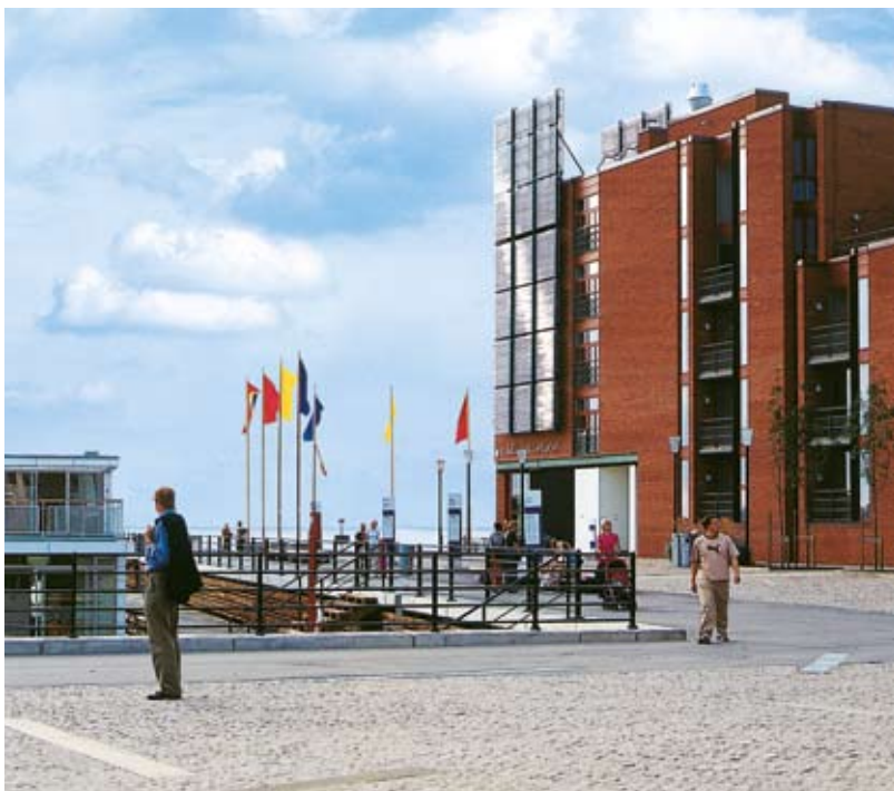
Рис. В.1.7-1 Фасад здания с коллекторами Viessmann в «Городе будущего».
