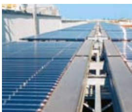
Рис. В.1.6-12 Монтаж на плоской крыше (в горизонтальном положении).
