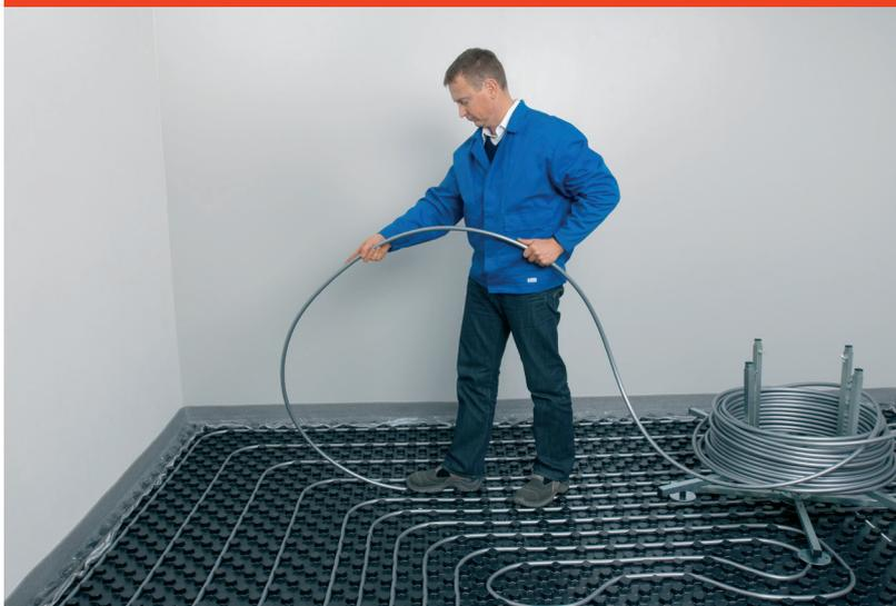
Отопление системой "теплого пола" позволяет эффективно использовать низкотемпературное тепло от теплового насоса.
