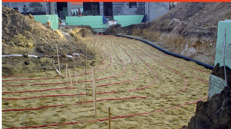
Пластиковые трубы земляного коллектора укладываются на глубине от 1,2 до 1,5 м.
