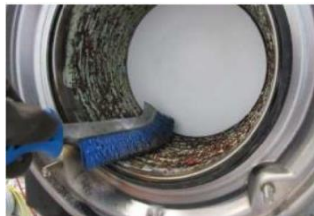
2. Очистить спирали с помощью щетки с неметаллической щетиной.
