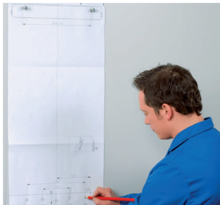
1. Предварительная разметка с помощью монтажного шаблона
