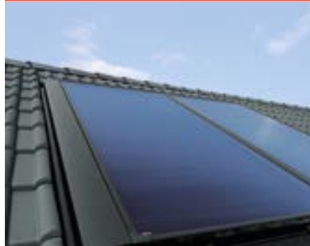
Рис. 27 Пример установки в крышу
